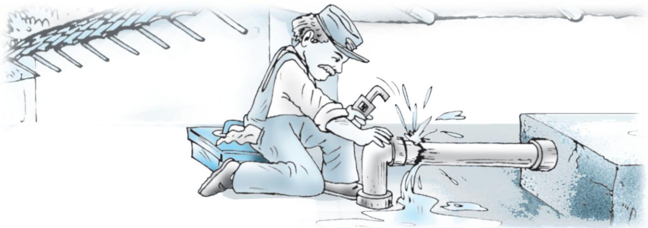
**Mantenimiento Correctivo:** Es el conjunto de acciones que se deben realizar para reparar daños en los sistemas las cuales pueden causar paralización total o parcial del servicio. Por ejemplo la reparación de tanques, tuberías, válvulas etc.
