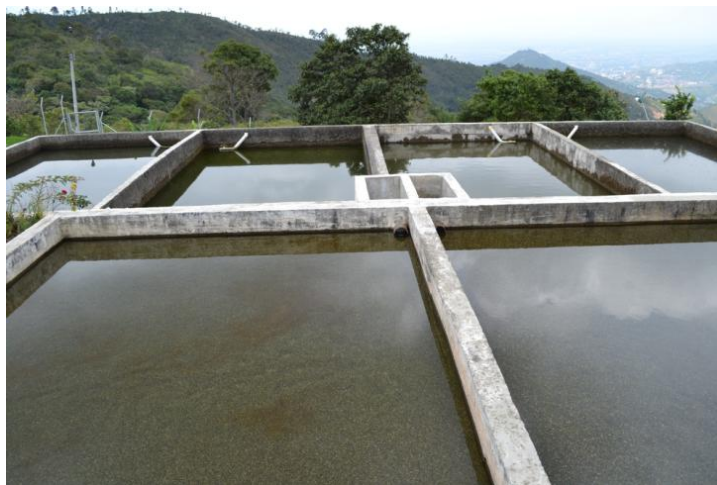
Figura 3. Planta FIME del Acueducto Golondrinas en la zona rural de Cali.
